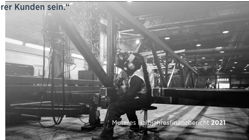
Fertigungsteile für eine Autobahnbrücke
